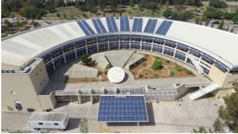
مشروع الطاقة الشمسية المندمج في بناء معهد البحوث الصناعية
